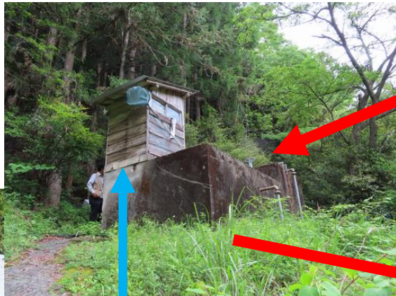
浄水処理施設
