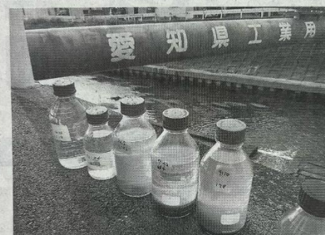
工業用水道の導管と清掃 前後の水の汚れの比較
